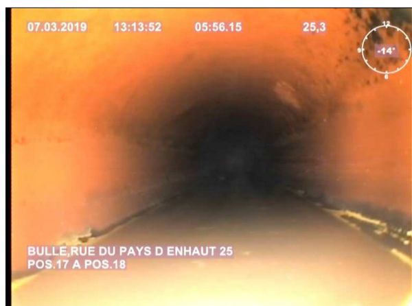
Photo: 9_6A 25.3m, Niveau d'eau, effluent trouble
