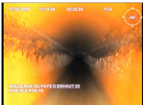
Photo: 8_4A 17.3m, Remarque générale / Traces de mise en charge
