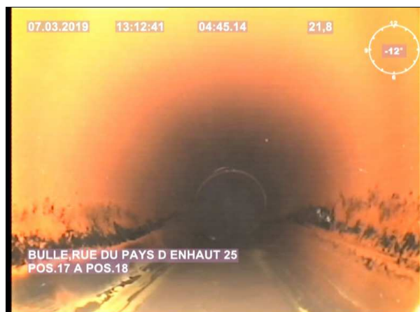
Photo: 9_4A 21.8m, Niveau d'eau, effluent trouble
