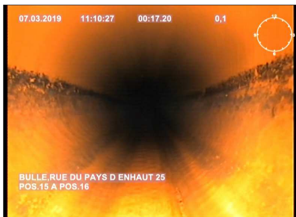
Photo: 8_2A 0.1m, Remarque générale / Traces de mise en charge
