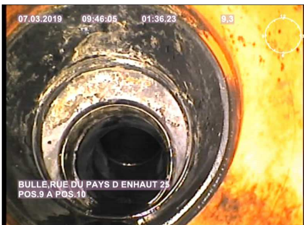
Photo: 5_4A 9.3m, Modification de la section de la canalisation: circulaire / Réduction du diamètre
