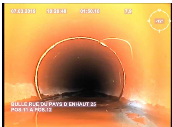
Photo: 6_5A 7.9m, Fissure longitudinale , de 12 à 3 h. / À la liaison de tuyau
