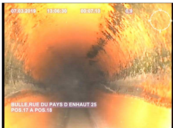
Photo: 9_2A 0.9m, Remarque générale / Traces de mise en charge
