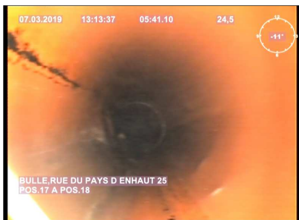
Photo: 9_5A 24.5m, Canalisation déformée horizontalement , de 12 à 12 h.
