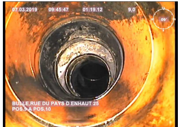
Photo: 5_3A 9m, Changement du matériau de la canalisation: PE, polyéthylène
