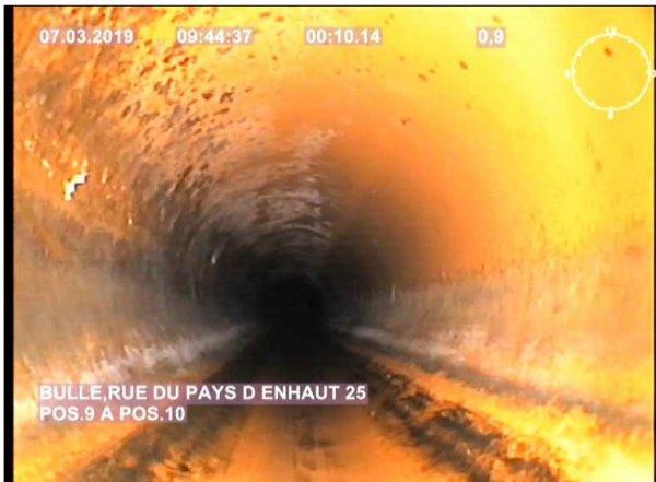
Photo: 5_2A 0.9m, Remarque générale / Traces de mise en charge
