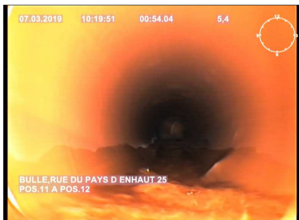
Photo: 6_2A 5.4m, Canalisation déformée horizontalement , de 4 à 6 h.
